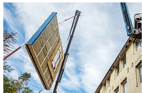
Nur noch Sekunden bis zur Verankerung am Gebäude: Die Innenansicht des Fassadenteils lässt gut den fertig verbauten Dämmstoff erkennen
