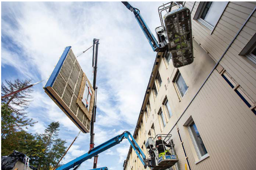
180 vorgefertigte Fassadenelemente inklusive Dämmung, Fenstern und Rollläden sowie Lüftung wurden von Renowate in der Zeppelinstraße verbaut.
