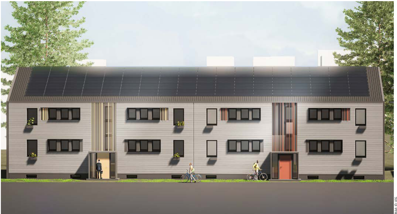
Das LEG-Zukunftshaus nach Fertigstellung (Visualisierung): Neben der Montage von energieeffizienten Gebäudehüllen werden auch Indach-Photovoltaikanlagen und hocheffiziente Wärmepumpen installiert.
